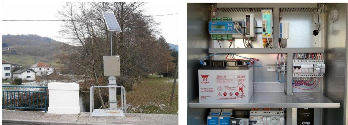
**Figure 3.2 : Coffret d'une station hydrométrique à relation hauteur-débit à l'amont d'un pont, La Moselle à Fresse sur Moselle, 72 km<sup>2</sup> (DREAL Grand Est, UH Meuse Moselle)**
