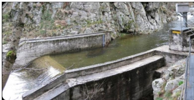
**Figure 2.3 : Seuil avec passe bas débit du Gage à Ranc de Piouche, affluent de la Loire, 18 km<sup>2</sup>, (EDF-DTG)**
